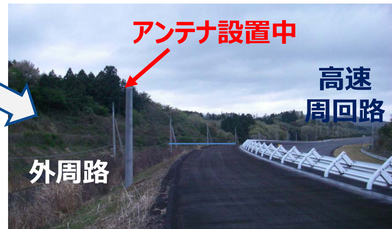
高速周回路—外周路間の法面
